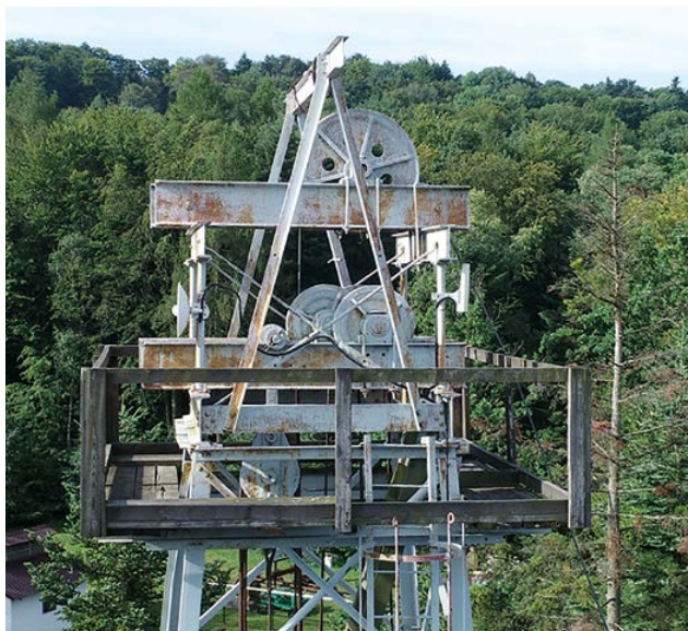
Foto. 10. Korona wieży urządzenia wiertniczego udarowego Bitków, [1]
